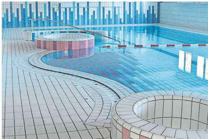
Das bestehende Becken eignet sich nicht mehr für den Schwimmunterricht.
